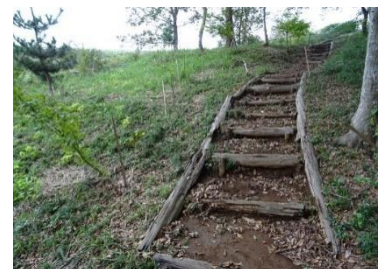
朽ちかけている蹴込み(逐次プラスチック化の予定)
