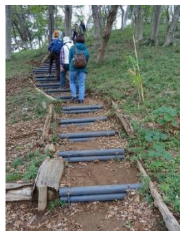
プラスチック化された階段の蹴込み
